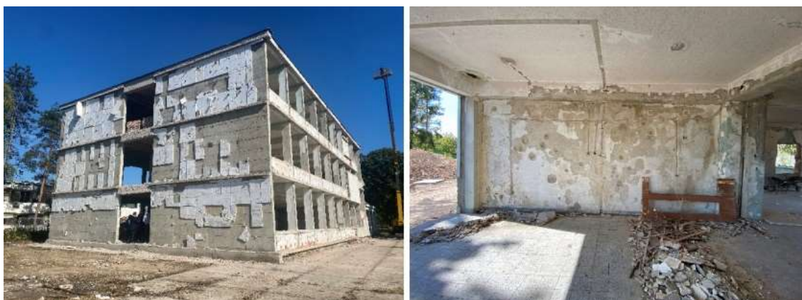
Slika 2. Zgrada nekadašnje mesarsko-prerađivačke škole koju je potrebno rekonstruirati u sklopu ovog Projekta (Zajma 9127HR)
